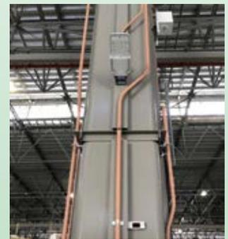
工場の柱は鉄骨造なのでセンサーの取付はマグネットシートで取り付けます。設置高さは人感センサーは1.5m 高さ温度センサーは1.7m程度の位置に取り付けました。
