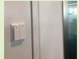
右図のようにTepraでAUTO・1・2・OFFを貼り使用されています。AUTOを押すと予め設定された照度、温度で照明と空調が稼働します。
