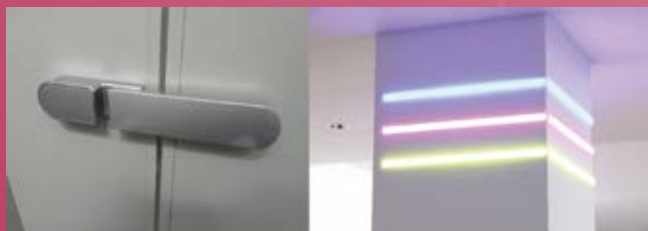
図2 ドアロッカーを用いたトイレ満室表示
