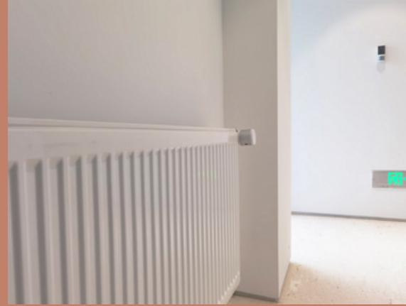
温差能供电的无线无源阀门
