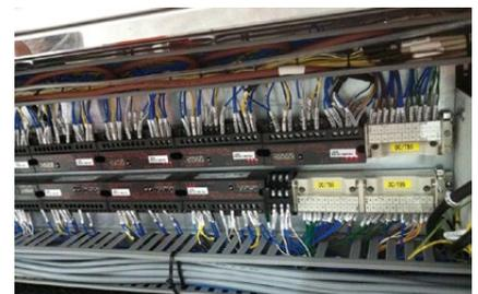
写真2 各処理槽の個別制御部
