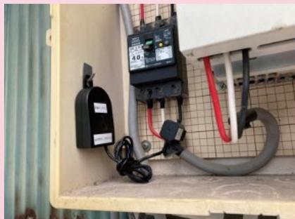
養鶏場の電流を計測しているセンサー (Pressac Sensing 社製 3PCT-60A)
