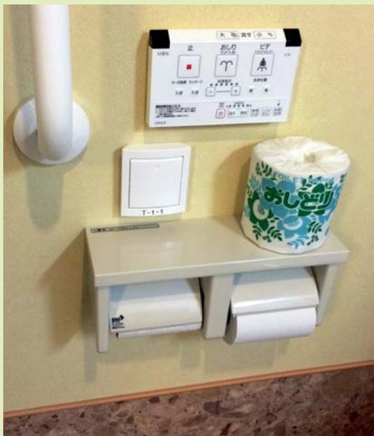
トイレの隣にEnOceanの電池レス呼び出しボタンを設置。
