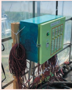
泉州電業社製 アビルヒータ制御パネル
