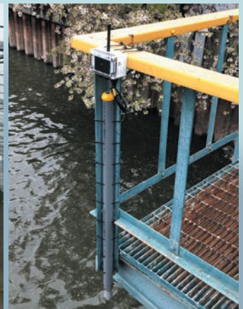
水位センサー設置状況
