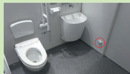
トイレへの設置
