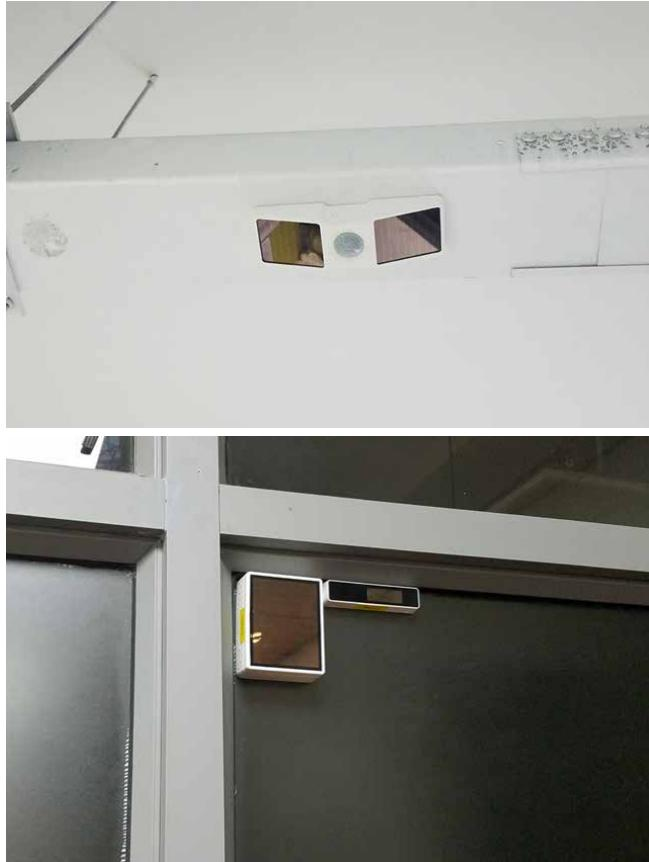
这些EnOcean设备被无线连接到Niagara建筑管理控制平台，同时DALI灯具也连接到该平台。系统可根据Fulham用户的要求，对来自EnOcean无线设备和DALI设备的数据在平台内自动互通完成运作。
