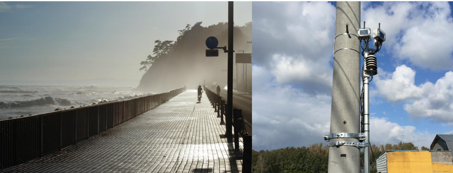
EnOceanのエネルギーハーベスティング長距離無線センサーソリューションは、北海道から沖縄県と全国各地に設置し、高温あるいは低温条件、高温多湿環境、南国の強い日射条件のほか、台風などの風雨、海水による塩害、農薬・肥料が散布される条件下でも数年間、十分に耐えることを実証し商業化を開始しました。
