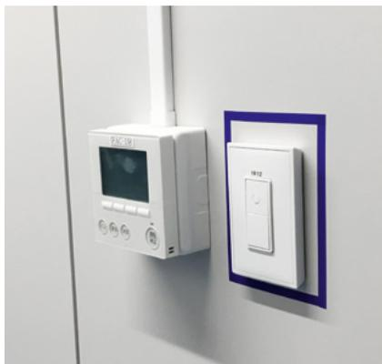
細かく分割することで、無駄な電力の削減を行っています。その照明システムとはLONWORKSを用いてシステムを接続。EnOceanのスイッチから受け取った信号を、LONWORKS経由で照明システムに受け渡して制御を行っています。工場内の広範囲にわたり32台設置したEnOceanスイッチで、小まめな消灯を行っています。また、iPadを従業員用の入口に常設。最終退出者が照明の点灯状態を平面図上で確認して、消し忘れを防ぎます。EnOcean無線スイッチと合わせて全ての照明をiPadで一括管理する内田洋行の提案が、無駄なエネルギーを使用しないというサカエの姿勢と合致、システムの導入となりました。
