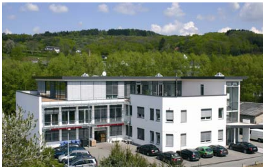
Bild 5: Bürogebäude, ausgestattet mit LON/EnOcean Technologie (Mit freundlicher Genehmigung der Thermokon Sensortechnik GmbH.)
