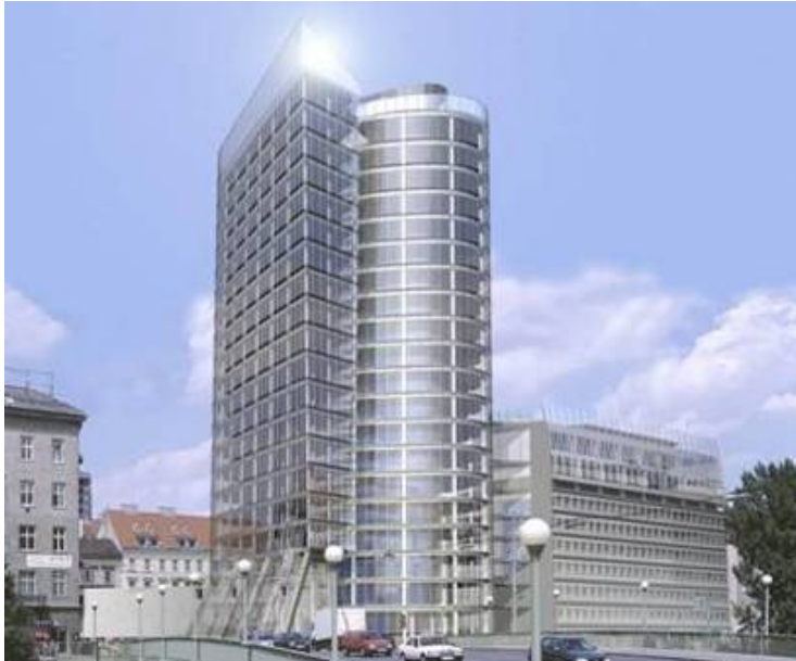
Bild 1: UNIQA-Tower in Wien. Der Backbone verbindet viele Stockwerke. (Quelle: © Uniqa Versicherungen AG. Mit freundlicher Genehmigung von Johnson Controls und der Thermokon Sensortechnik GmbH.)
