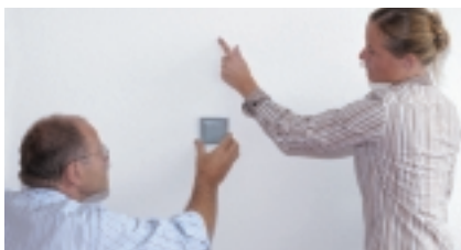
Kein Wände aufstemmen, kein Dreck: Die batterie losen Wandsender einfach aufkleben!
